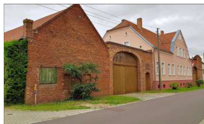
Vierseithof: Blick auf einen Vierseithof im Kleinen Dorf, Lostau.
