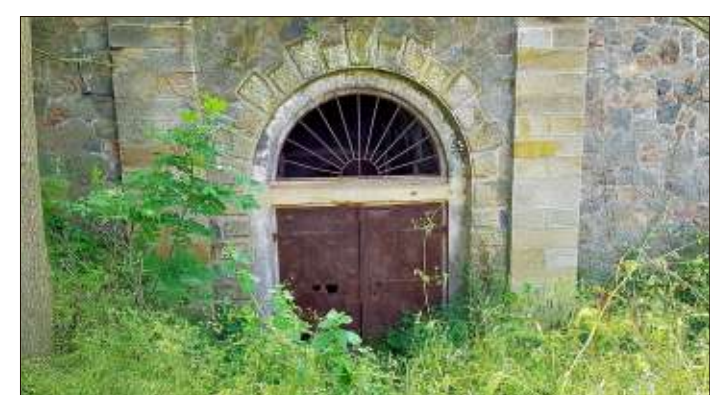
Eine Gruft kurz vor Groß Ammensleben.
