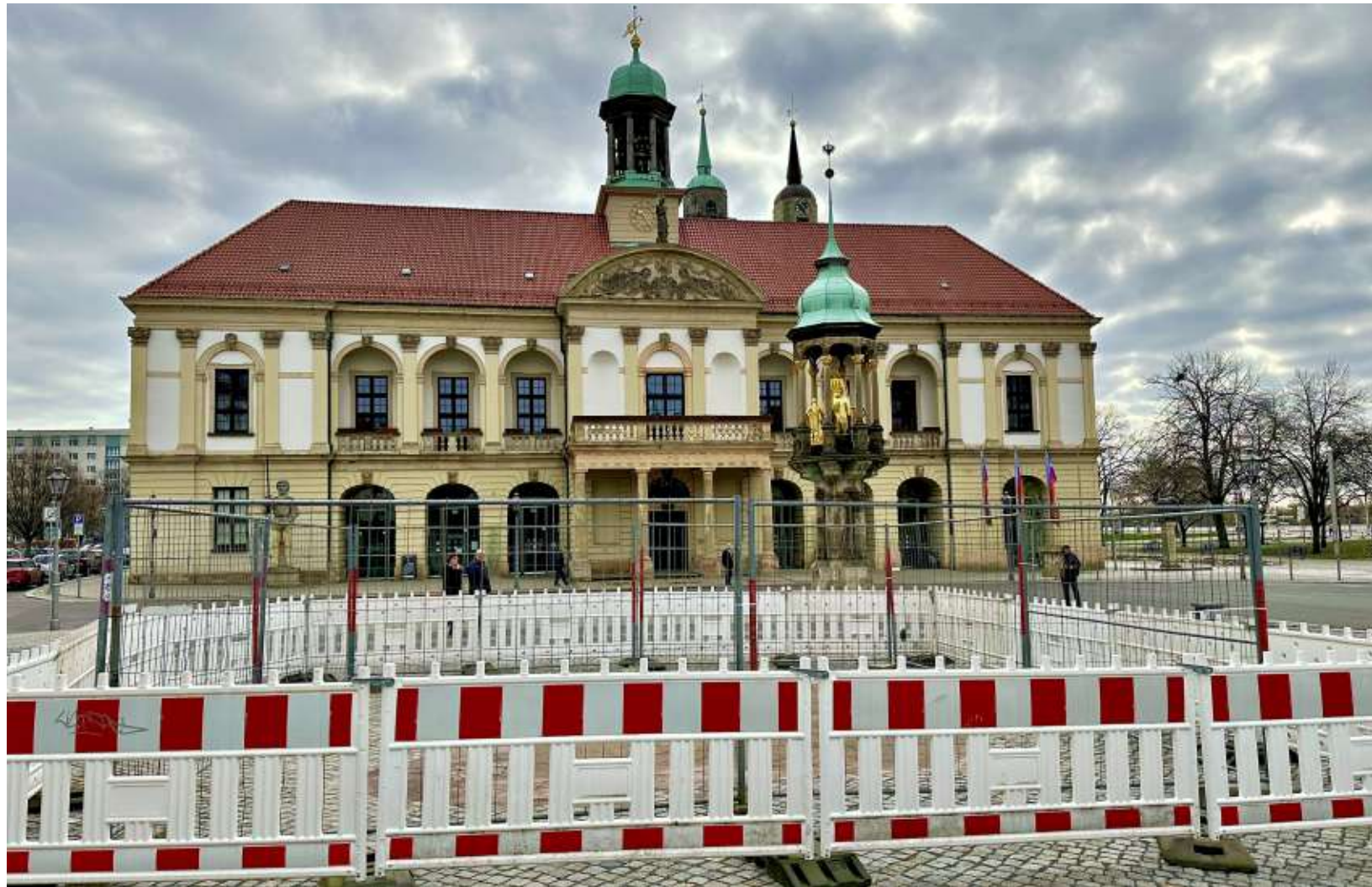
Baustelle Alter Markt: Auf dem Platz vor dem Alten Rathaus wurde das Fundament für den Weihnachtsbaum untersucht. Die Baken sollen bald verschwinden. Dann sollen unter anderem Blumenkübel für Farbtupfer sorgen.
